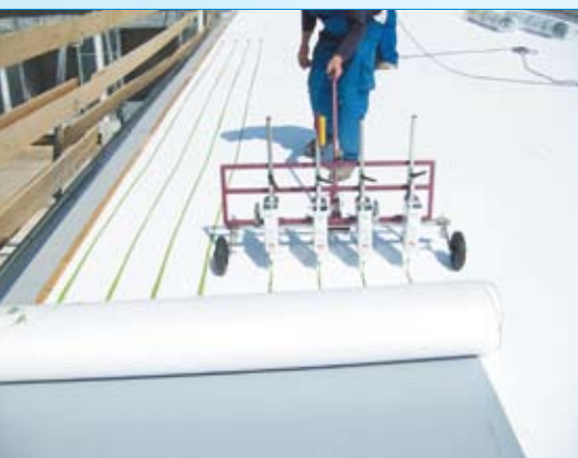
Aufbringung des Dachbahnenklebers
