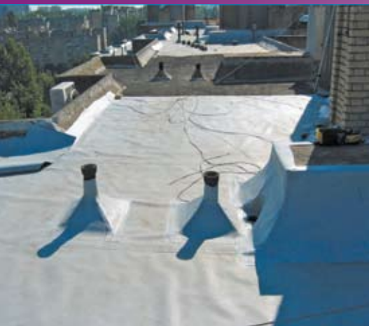
Verklebtes Dachsystem mit AUSTROPLAN FG+V
