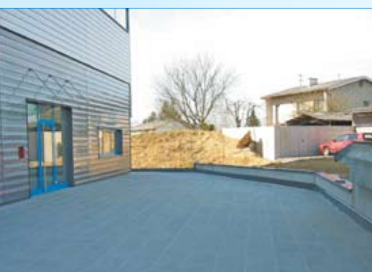
Abdichtung von Nutzsichten unter Auflast
