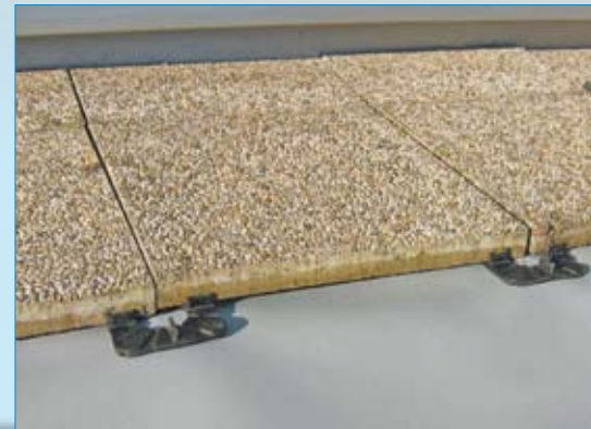
Terrasse mit AUSTROPLAN Dachbahnen abgedichtet und mit Betonplatten ausgelegt
