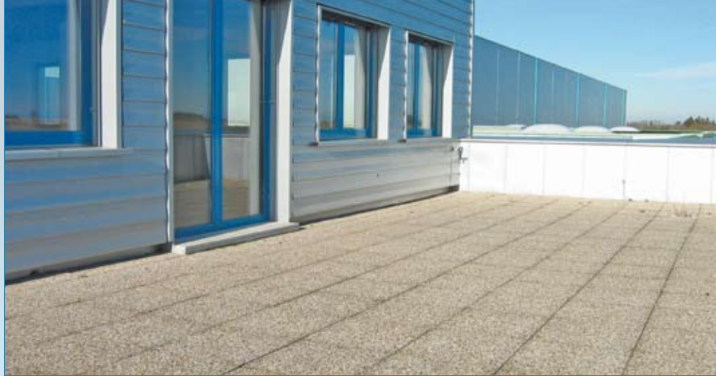
Terrasse mit AUSTROPLAN Dachbahnen abgedichtet und mit Betonplatten ausgelegt
