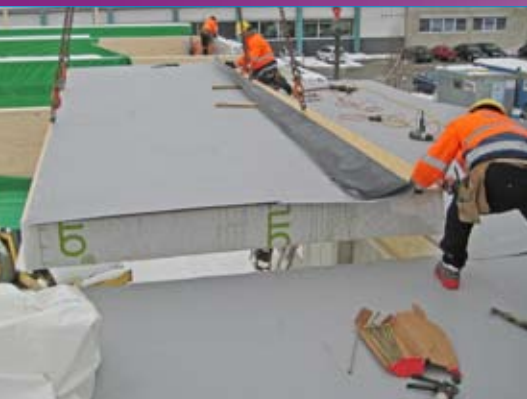
Verlegung von Fertigdachelementen
