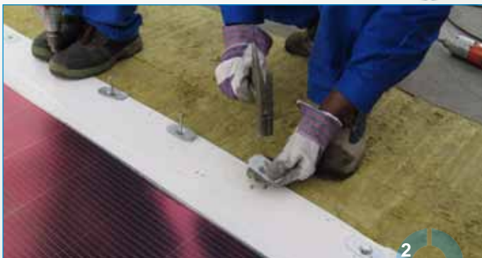
mechanische Fixierung der PV-Module
