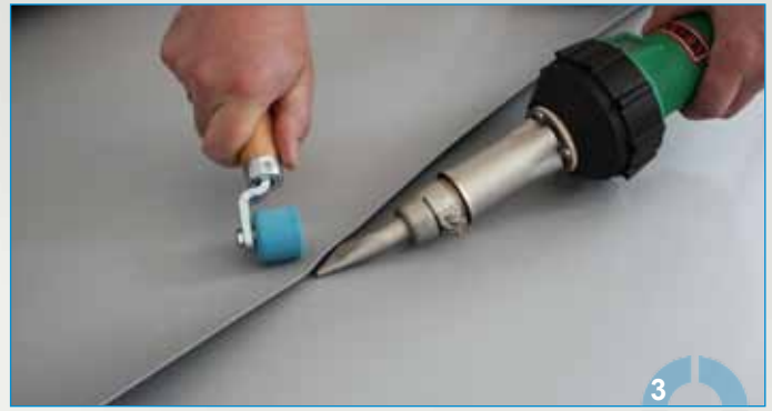
Handverschweißung mit Handgerät
