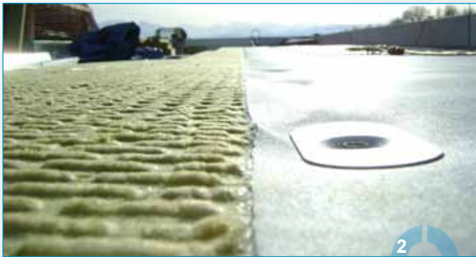
mechanische Fixierung der PV-Module
